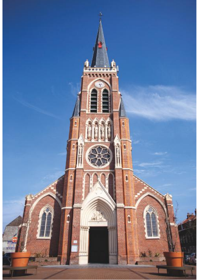
La toiture de l'église sera rénovée en 2022
