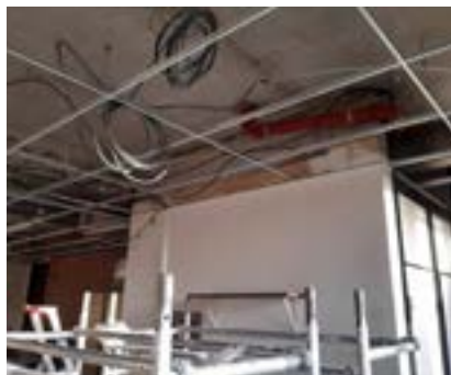
Travaux d'isolation de l'Hôtel de Ville
